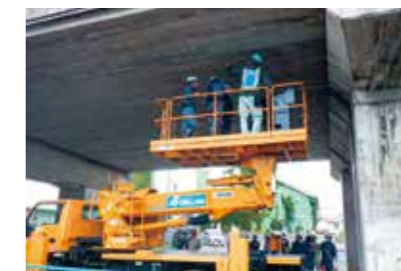
道路インフラメンテナンス工事現場見学会
