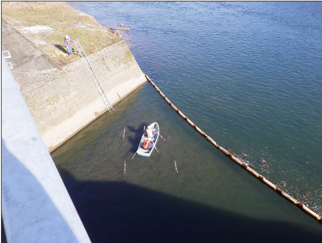
作業状況 1 堆積土砂調査
