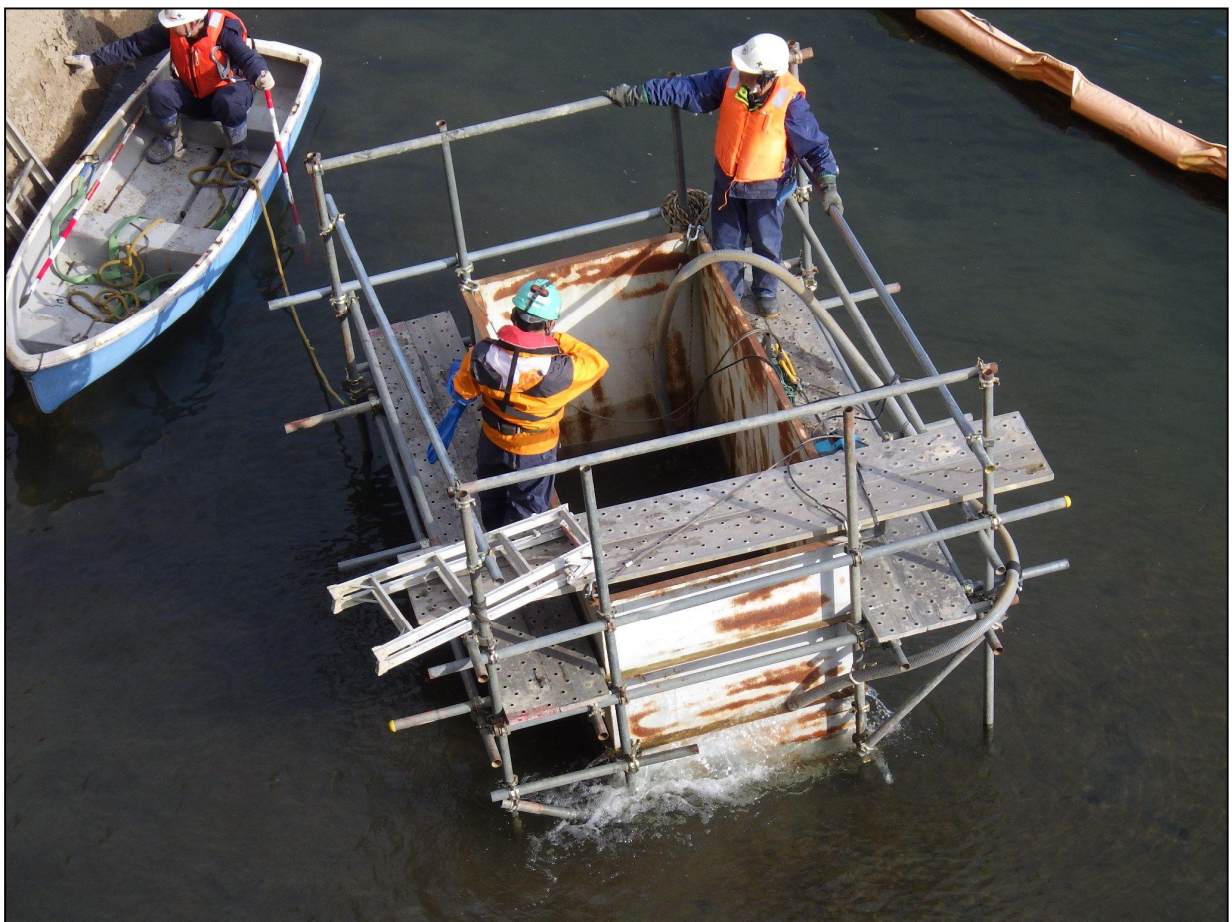
作業状況 4 ポンプ抜水
