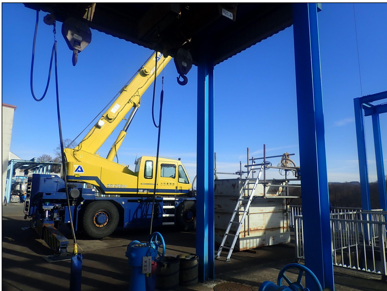
作業状況 2 仮設鋼製枠準備
