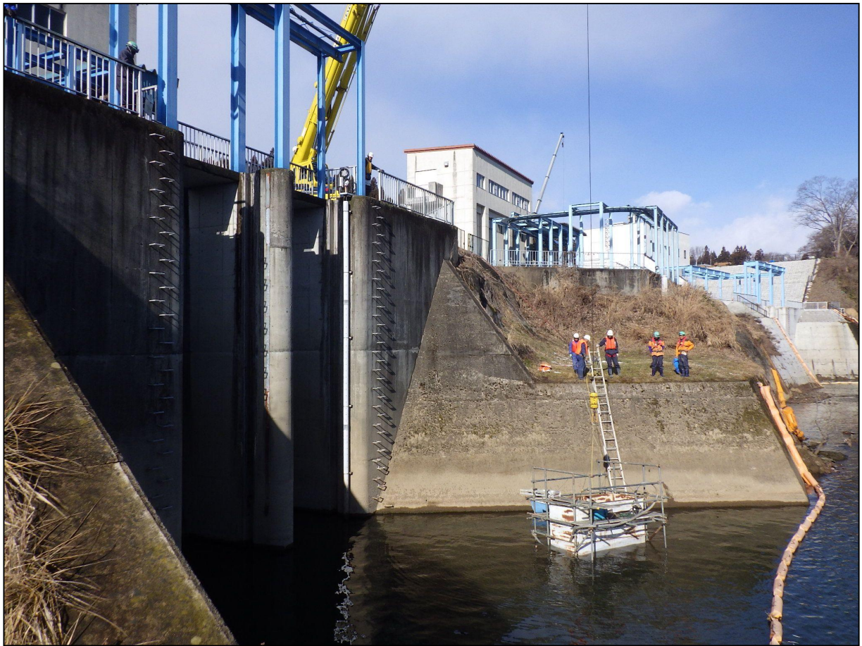
作業状況 3 仮設鋼製枠設置
