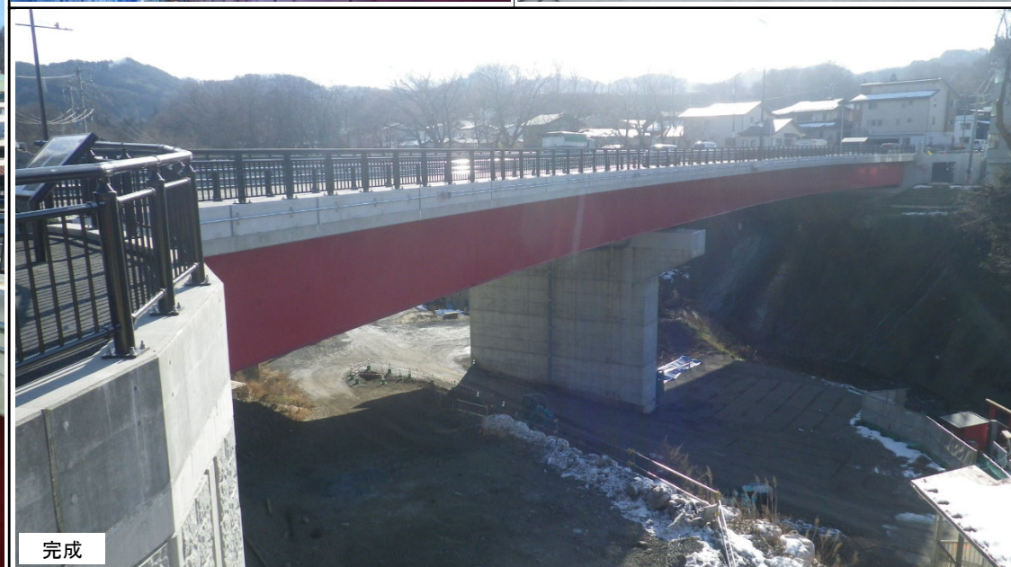
既設桁と新設桁の高さを調整し、添接板により結合
