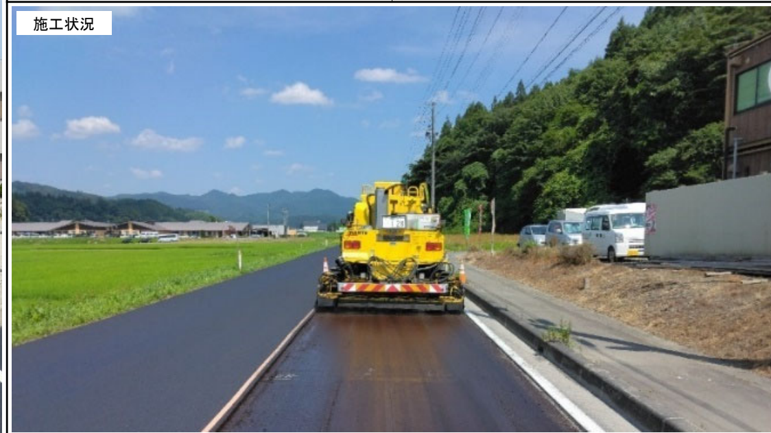
レーザープロファイラによる横断測量作業状況
