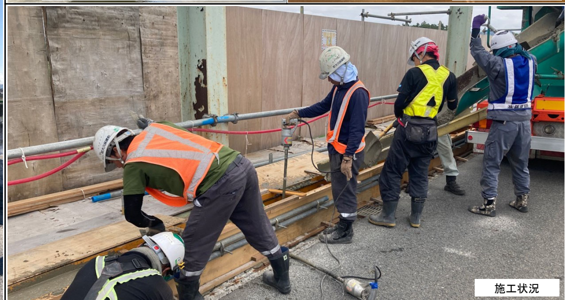
先行床施工式フロアシステム吊足場設置状況
