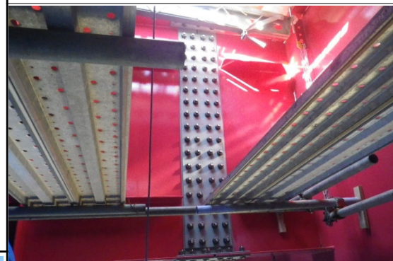
既設桁と新設桁の高さを調整し、添接板により結合
