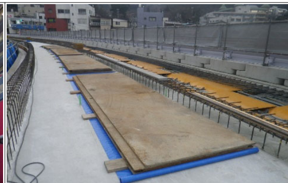
新設桁のキャンバー調整の敷き鉄板 敷き鉄板は横桁の段差を測定しながら重量を調整
