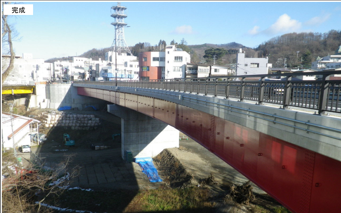
既設桁と新設桁の高さを調整し、添接板により結合
