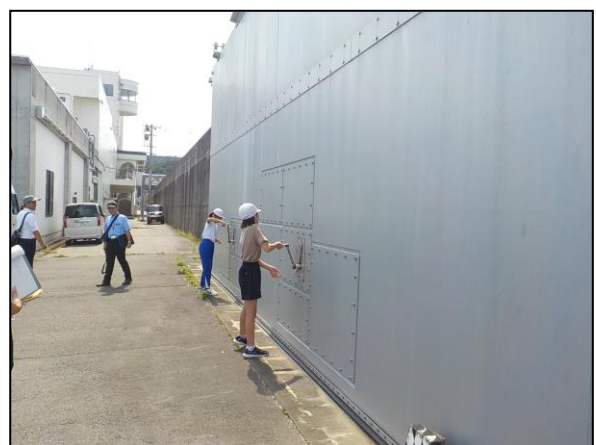
久慈港陸閘手動操作
