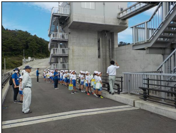
津波防災施設（野田水門）見学
