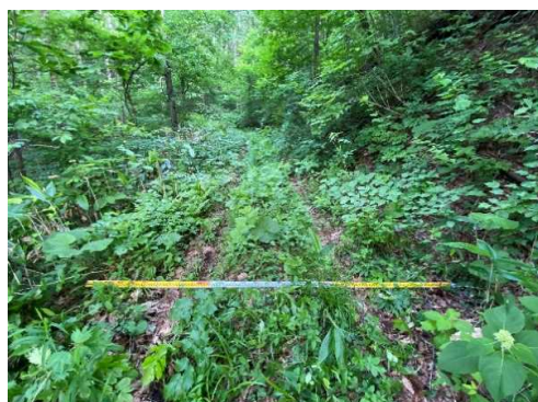
作業道 幅=3.0m
