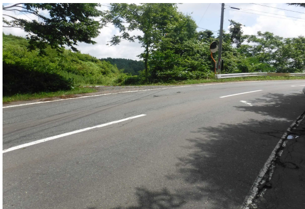
国道455号線からの林道取付状況
