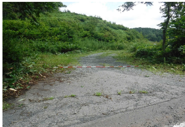
事業区内の林道状況(幅員 4.0m)
