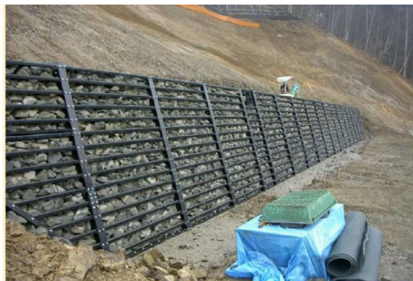
鋼製枠工
