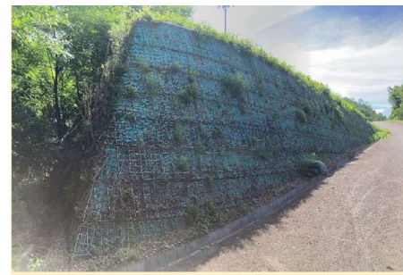
ジオテキスタイル補強土壁工
