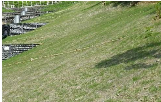
崖面以外の傾斜地への 植生の導入・筋工等の措置
