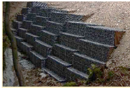
大型かご枠工
