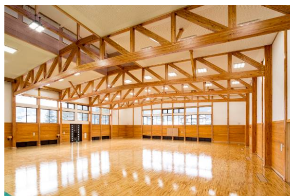
トラス梁を採用し広い空間を確保
