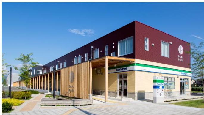
柔らかな印象を与える柱、梁、木製ルーバー
