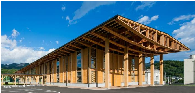
レンズ型トラス梁が象徴的な外観
