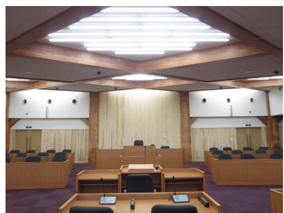
斜め格子梁により大空間を実現した議場
