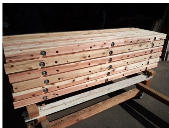
壁面に使用した杉柱材連結パネル
