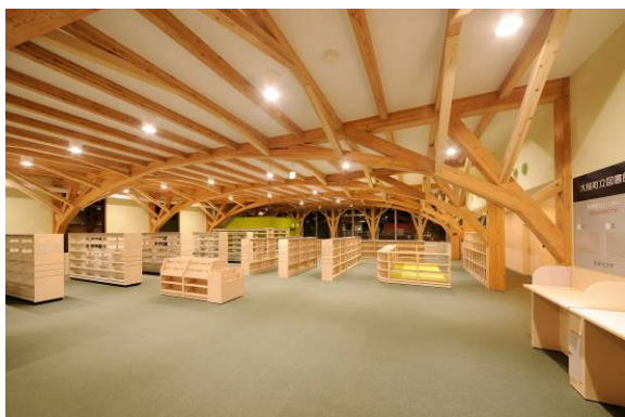
レイアウトの改変を考慮した無柱の大空間
