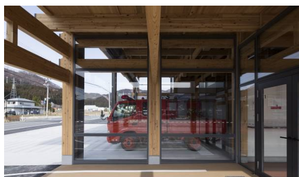
透明性の高いエントランスピロティ
