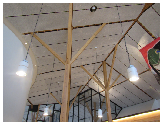
構造部（柱・梁・桁）の長尺のスギ無垢材
