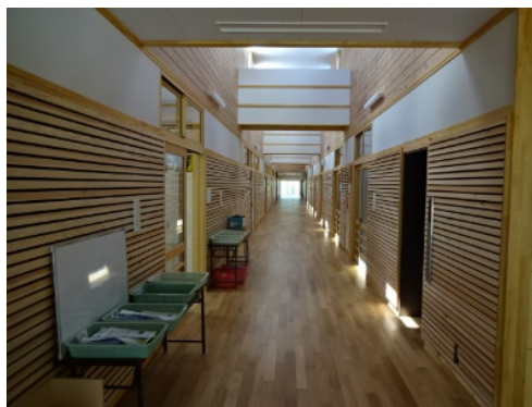
市産スギ材を利用した校舎の内部
