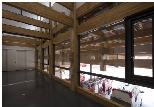
待機室から車庫を見る
