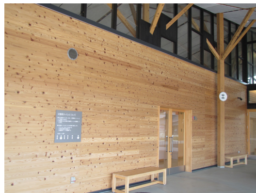
県産スギ材を多用した西側の外壁
