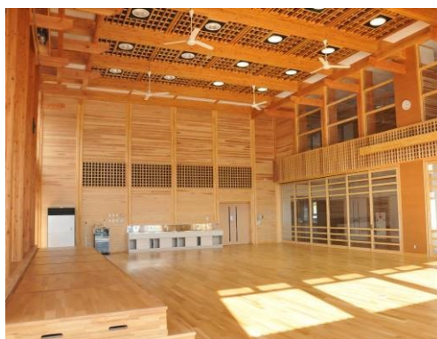
内装に市産スギ材を利用した早池峰ホール
