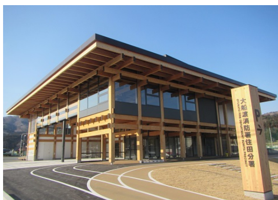
大きな庇が印象的な外観
