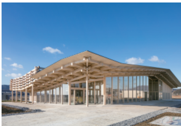
気仙大工による軒の出が深いせがい造りの外観
