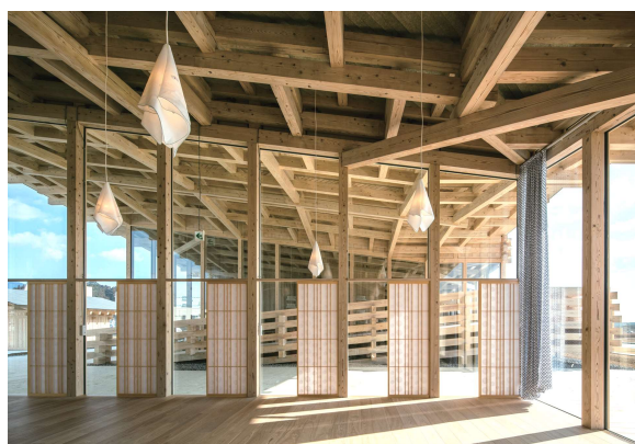
市産気仙杉の小屋組みを現しとした建物内部
