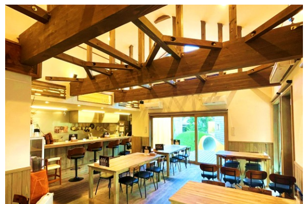
大梁、小屋組を表しとした内観
