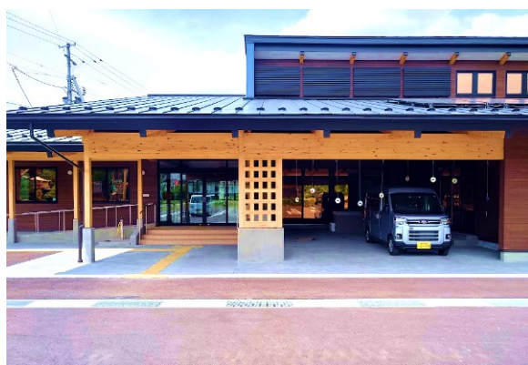
軒下部分の採光に配慮した格子壁
