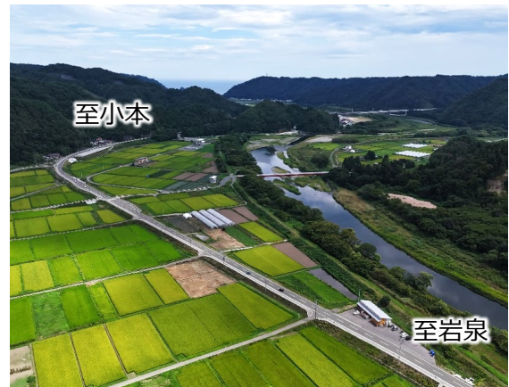
国道455号 中島地区
