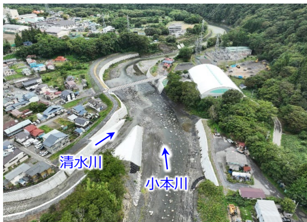
二級河川小本川 市街地地区
