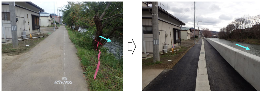
馬淵川 一戸町本町地区河川改修
