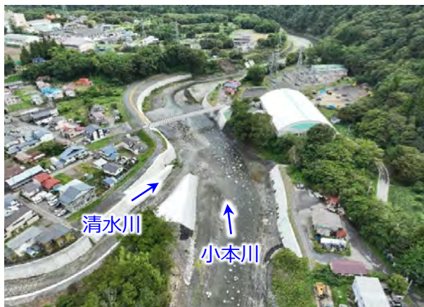
二級河川小本川 市街地地区
