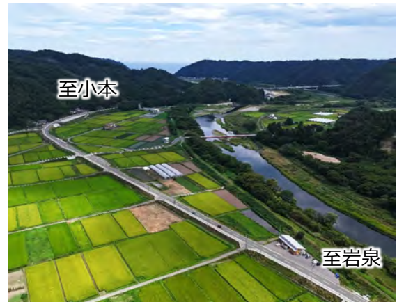
国道455号 中島地区
