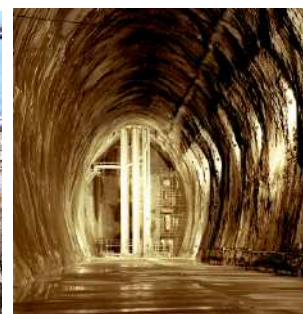
地下岩盤タンク
