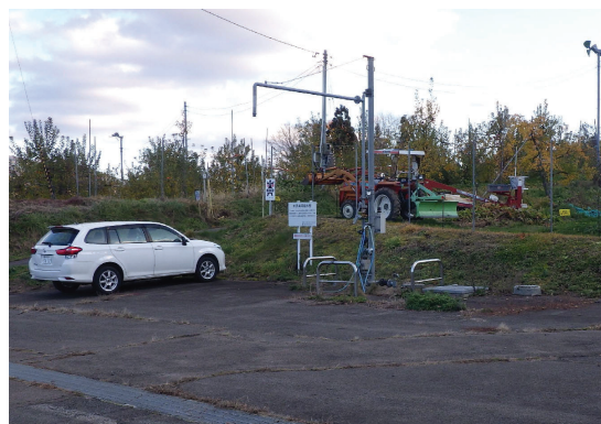
写真：共同給水栓設置状況
