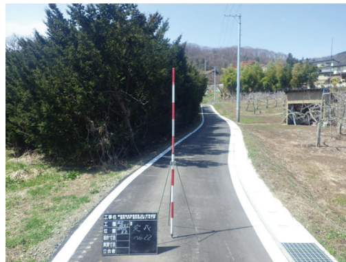
写真:農道(整備後)
