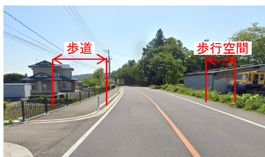
写真②（整備後）
