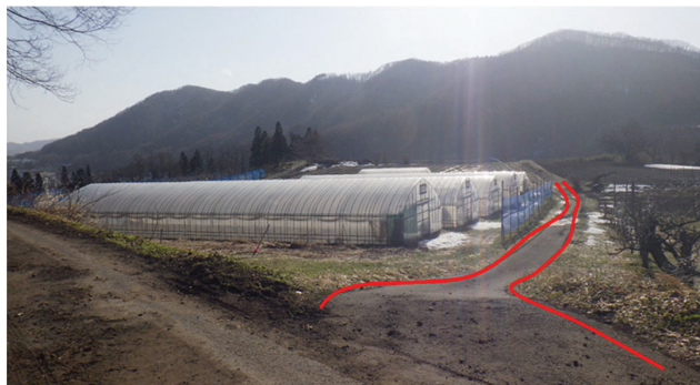
写真:農道(整備後)
