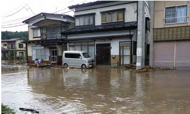
一戸町内の被害状況
