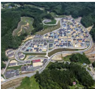
宮古市田老地区乙部団地 (防災集団移転促進事業)
