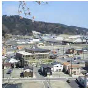
大槌町町方地区 (土地区画整理事業・ 津波復興拠点整備事業)
