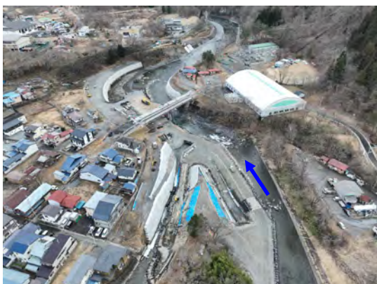
小本川：市街地工区の護岸工 施工状況
