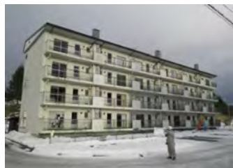
老朽化した公営住宅
