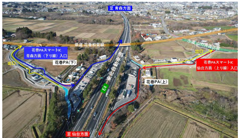
花巻PAスマートインターチェンジ
