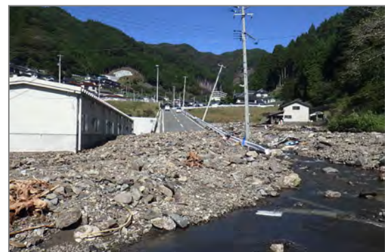
釜石市花露辺 土石流
