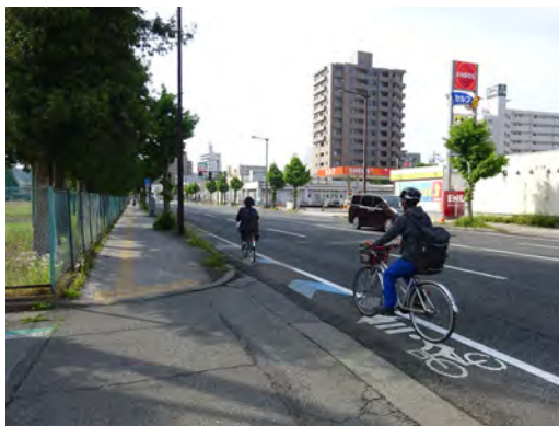
主要地方道盛岡横手線 矢羽根の整備
