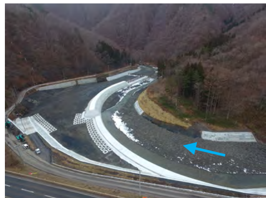
小本川：流木捕捉工 完成状況
