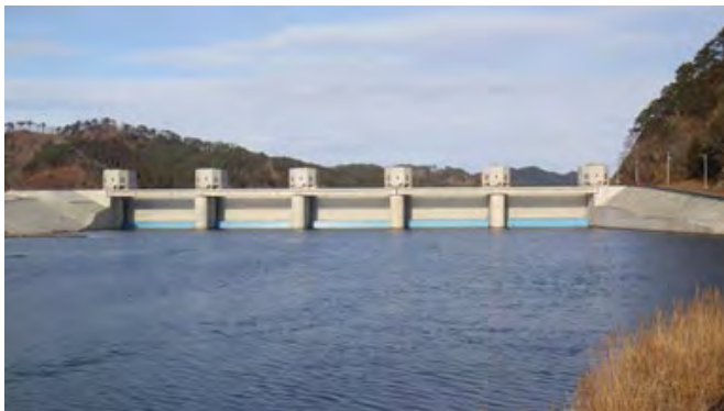
鵜住居川水門の閉鎖状況（釜石市）
