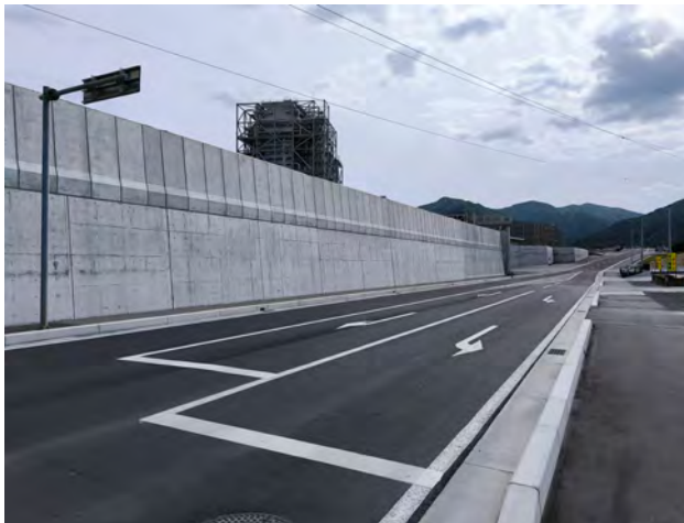
令和5年度完成 普金地区海岸（大船渡市）
