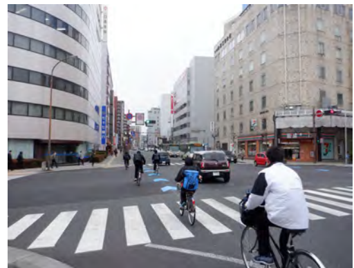
主要地方道盛岡停車場線 矢羽根の整備
