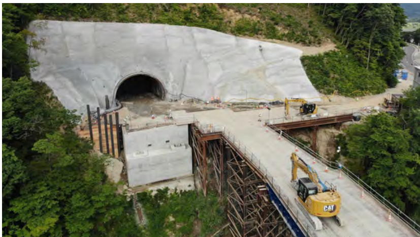
西和賀町側坑口
