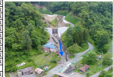
砂防堰堤完成状況：大沢（6）
