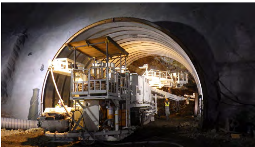
トンネル 計画延長：1,463m 掘削延長：775m (令和5年度末時点)
