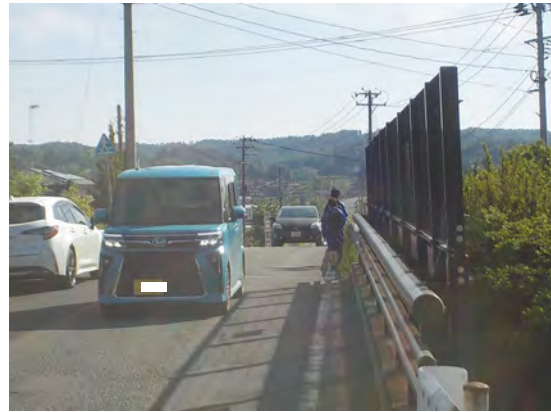
（整備中） 一般県道若柳花泉線 涌津工区（一関市）
