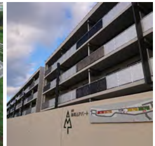
県営南青山アパート (盛岡市)
