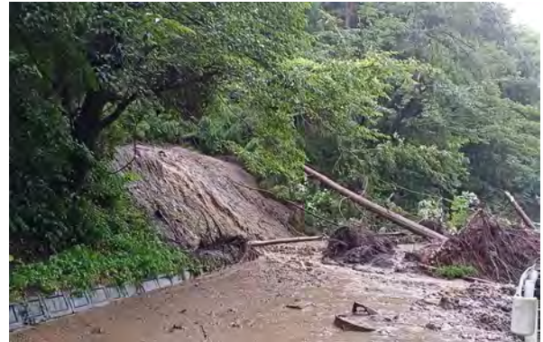
一般県道姉帯戸田線（一戸町）の被害状況
