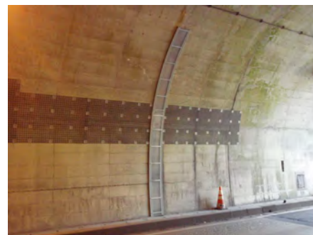
導水樋設置後
