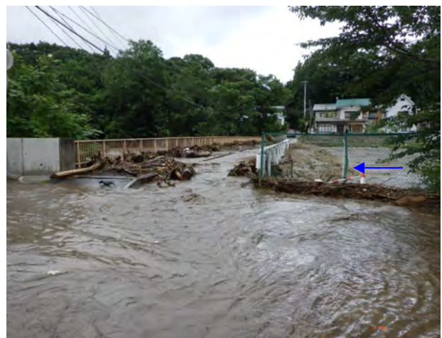
一戸町 岩根橋付近の浸水状況
