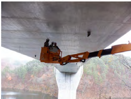
国道106号 築川大橋（盛岡市）
