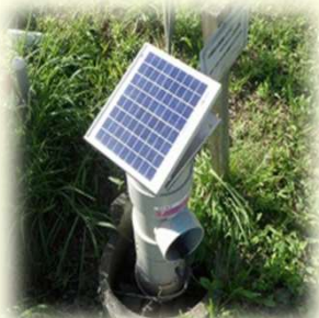
遠隔操作可能な 自動給水栓の設置
