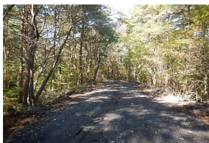
林道衣川線 幅＝4.0m
