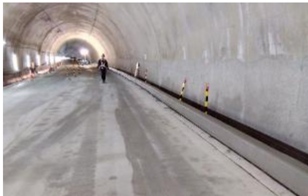
【西和賀側 舗装施工状況(R7.7)】
