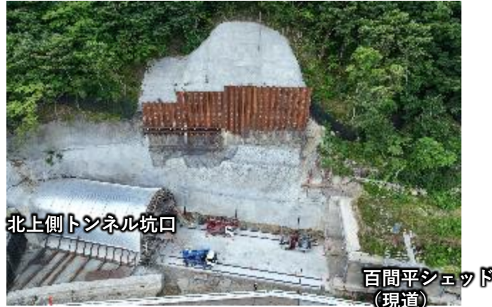
【トンネル起点側（北上側）(R7.8)】
