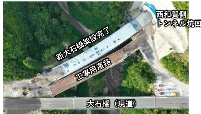
【トンネルの終点側（西和賀側）橋梁架設完了状況 (R7.8)】
