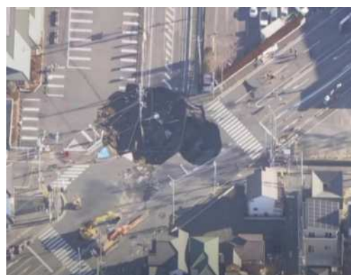
図 6.2 埼玉県八潮市における道路陥没事故の状況
