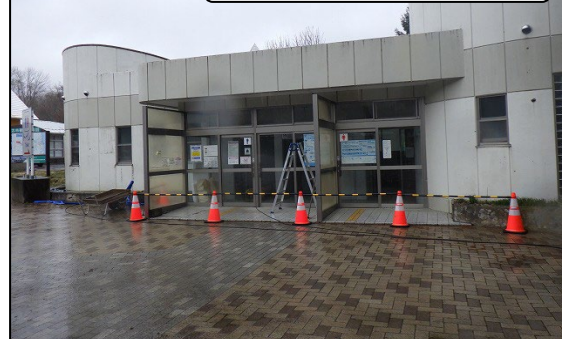
入口閉鎖状況
