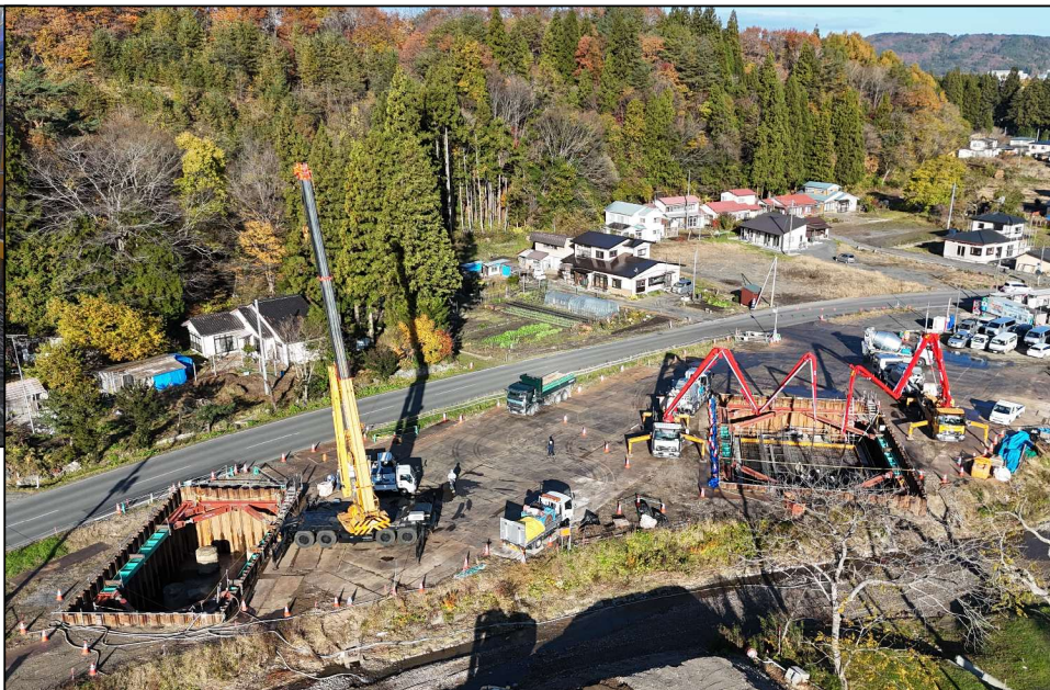
（写真右）私が担当している久慈市小屋畑川の橋梁下部工工事の施工状況です！
