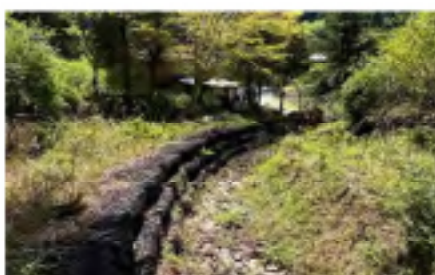
護岸工整備後
