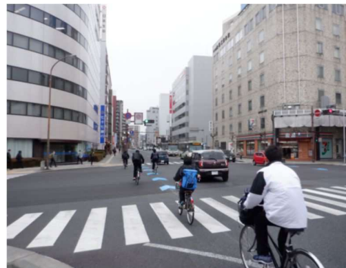
主要地方道盛岡停車場線 矢羽根の整備 （盛岡市）
