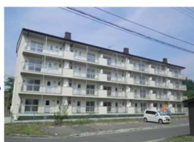
改修事業の実施 （バリアフリー化 ・省エネ化等性能の向上）
