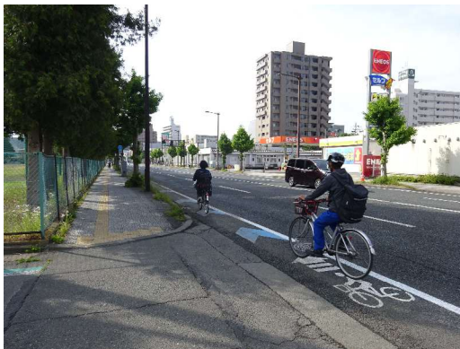
主要地方道盛岡横手線 矢羽根の整備 （盛岡市）
