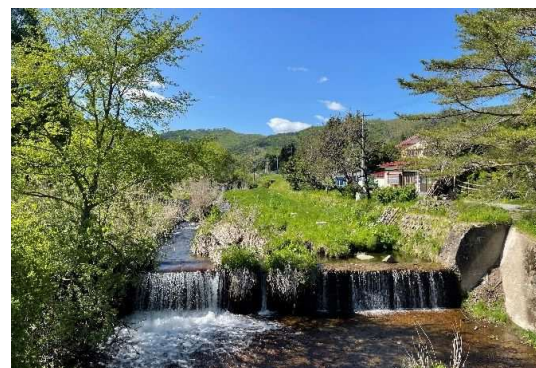
砂防設備修繕（緊急浚渫推進事業） 馬淵川川流路工（葛巻町）
