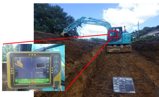
ICT建設機械による施工状況
