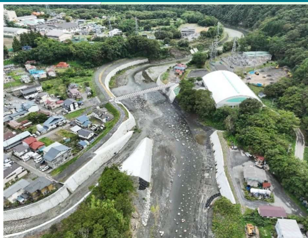
岩泉町：小本川の河川改修 (令和7年10月・全工区完成)
