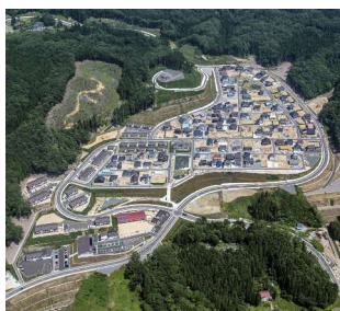
宮古市田老地区乙部団地 (防災集団移転促進事業)
