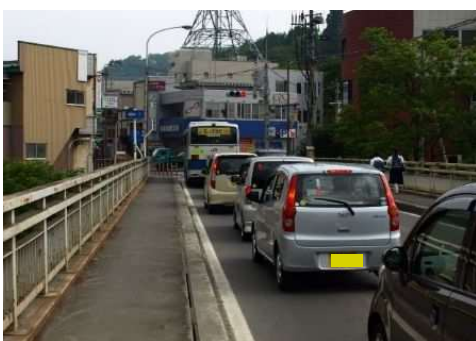
整備前（昭和25年完成・幅員9m）
