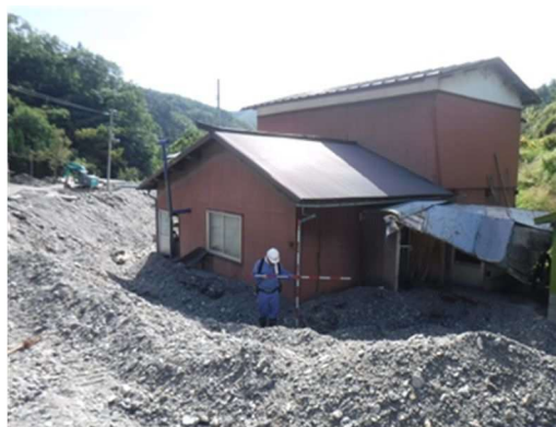
平成 28 年台風第 10 号の被災状況 (松橋川砂防堰堤の設置前)(岩泉町)
