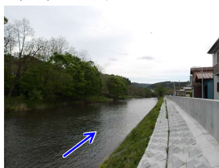
本町付近の改修状況（一戸町）
