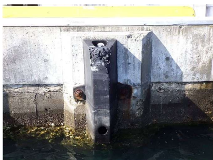
宮古港 鉏ヶ崎地区（防舷材の破損）（宮古市）
