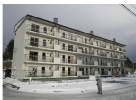
老朽化した公営住宅
