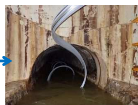
② 更生管投入
