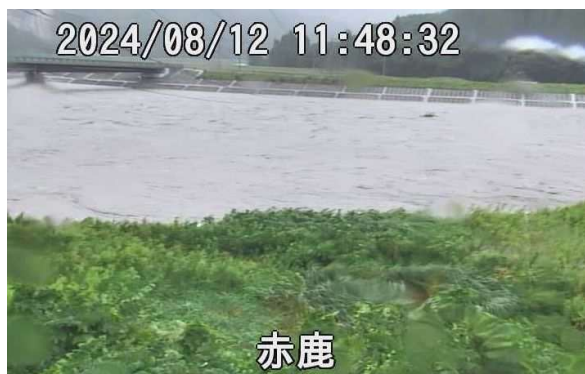
令和 6 年台風第 5 号の出水状況 (岩泉町赤鹿水位観測所)
