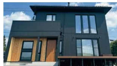
地域性への配慮 (住み継がれる住宅)
