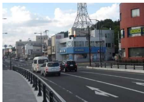
整備後（令和5年12月完成・幅員16～19m）
