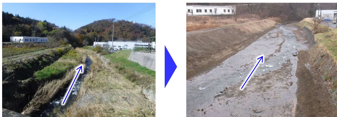
宮守川の河道掘削の状況（遠野市）
