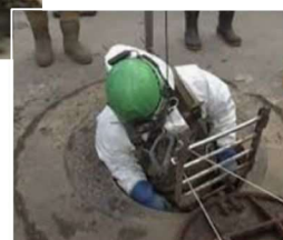
市町村向けの法定施設点検見学会
