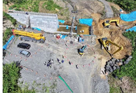
砂防堰堤工事の現場見学（ドローン操作体験） (令和7年9月・岩泉町立小川中学校)
