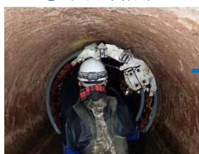
③ 更生管設置
