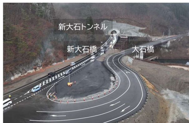
大石トンネル・新大石橋の整備状況
