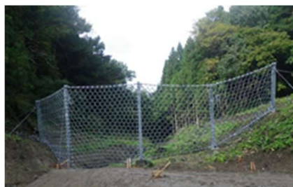
緊急対策完了状況：小安孫沢（葛巻町）
