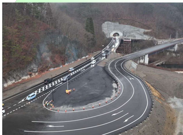
西和賀町：一般国道107号大石地区 (令和7年11月・大石トンネル開通)
