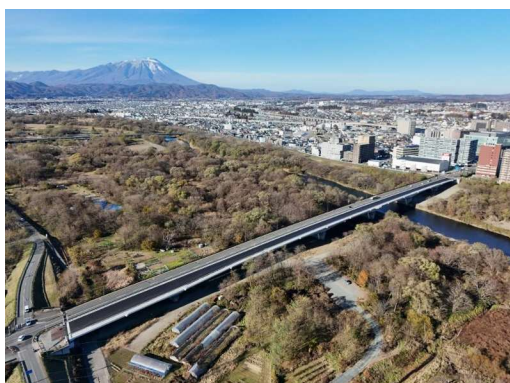
都市計画道路 盛岡駅本宮線 杜の大橋（盛岡市）
