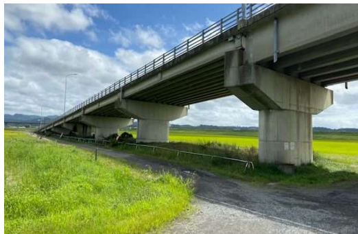
主要地方道一関北上線 中里橋（橋脚のコンクリート巻立工ほか）（一関市）
