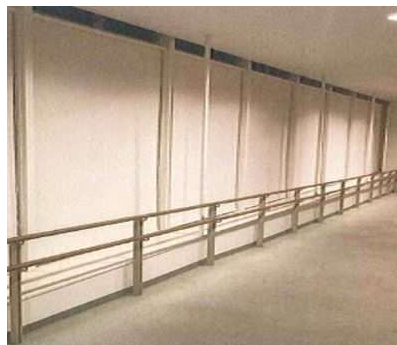
空港ターミナルビルの遮熱対策 （ロールスクリーン）
