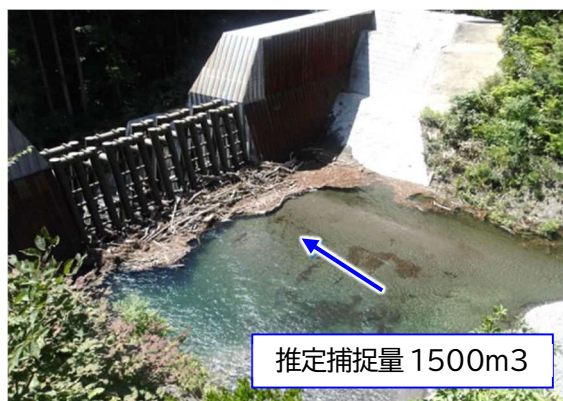
松橋川砂防堰堤の土砂・流木捕捉効果 (令和 6 年台風第 5 号)(岩泉町)
