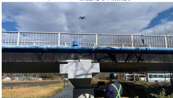
主要地方道 岩泉平井賀普代線 新普代橋（普代村）
