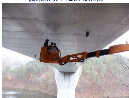
国道106号 築川大橋（盛岡市）
