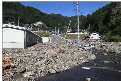
土石流の発生（釜石市）
