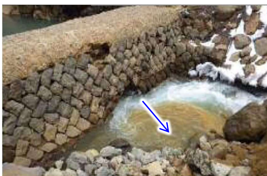
砂防メンテナンス事業（補助）砂防 長山砂防堰堤（雫石町）
