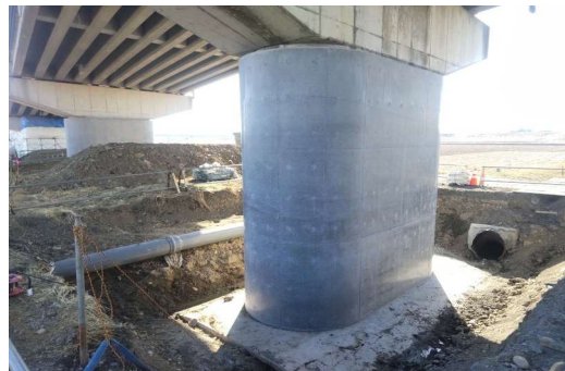
主要地方道一関北上線 中里橋（橋脚のコンクリート巻立工ほか）（一関市）
