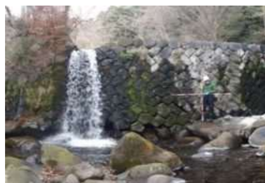
砂防メンテナンス事業（補助）砂防 細野第二堰堤（大船渡市）
