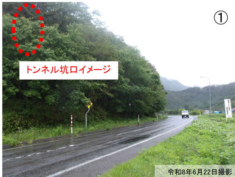
【トンネル坑口】 終点側のトンネル坑口
