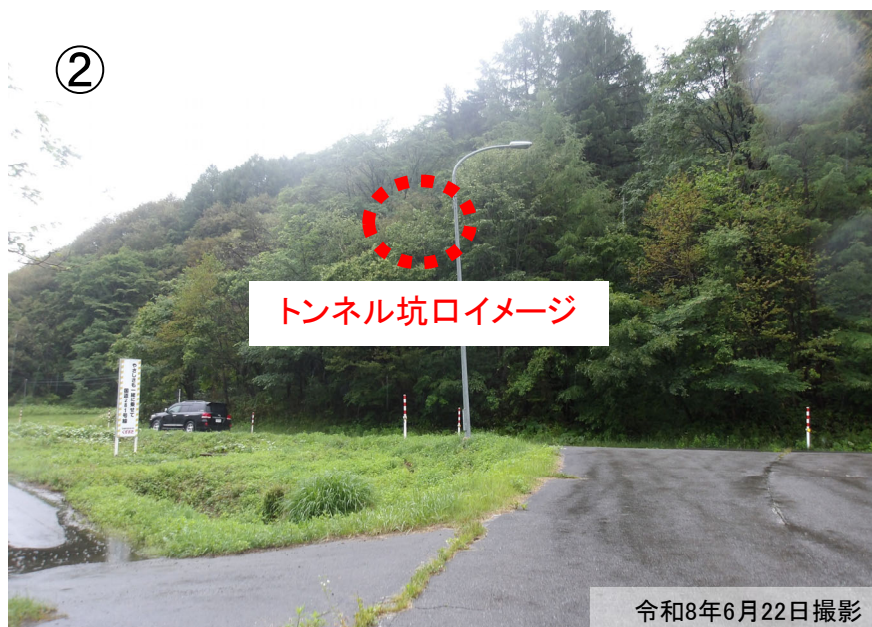
【トンネル坑口】 終点側のトンネル坑口(正面)
