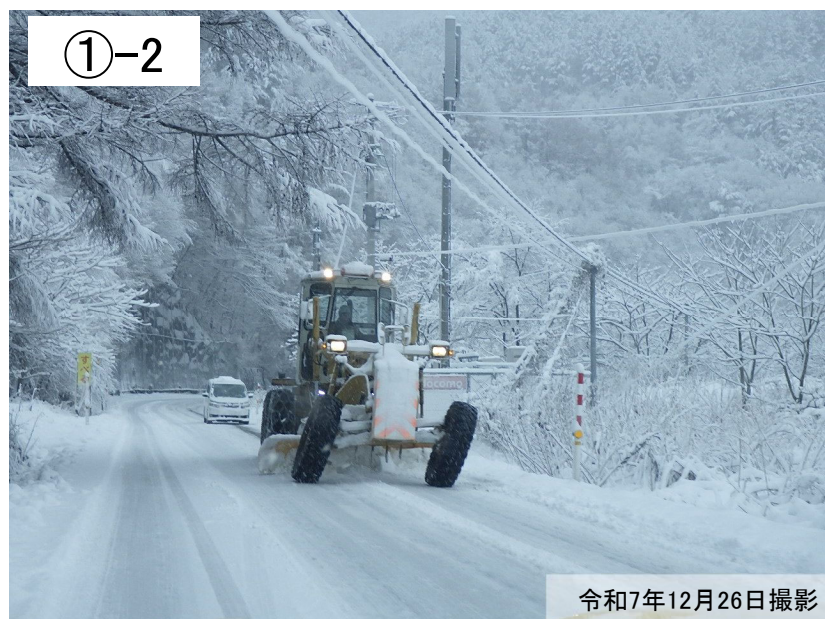
【現道課題】幅員狭小、線形不良箇所(冬期)
