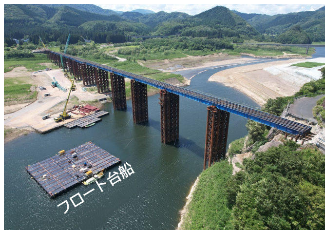
＜水上施工用フロート台船＞
