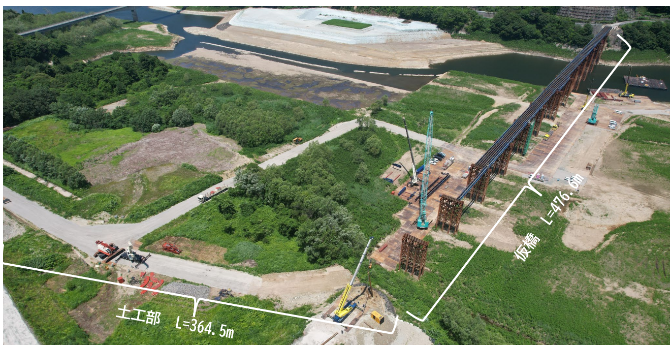
＜仮橋撤去状況（全景）＞
