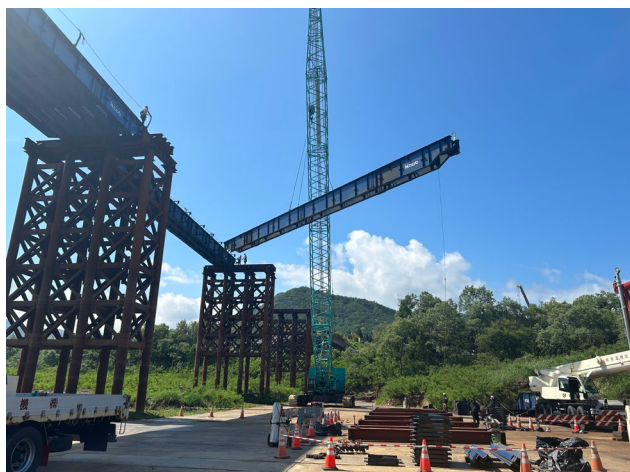
＜上部工（主桁）の撤去状況＞
