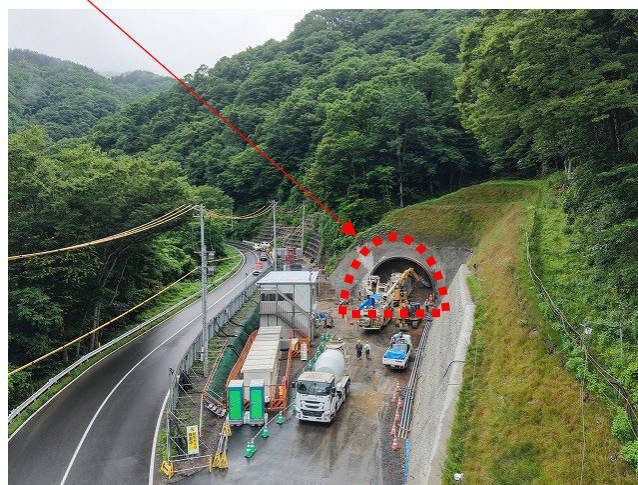
終点側(久慈市街地側)作業状況 (R8.7月)
