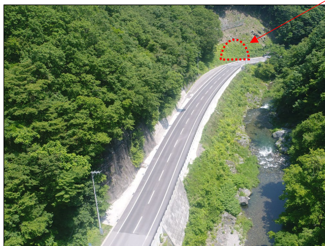
起点側(盛岡側)道路改良工事完成状況 (R8.7月)
