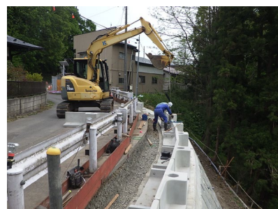
▲R8.5月 工事状況(小林工区)
