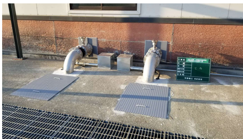
水中ポンプ設置完了
