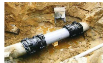
漏水防止のための整備
