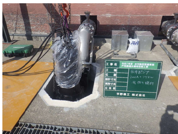
水中ポンプ設置状況
