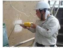
老朽化した施設の機能診断
